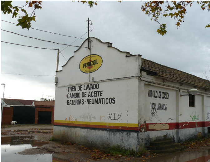
Ilustración 3: Vista parcial del barracón, utilizado como droguería. Podemos ver las antiguas escaleras de acceso al local y la puerta, ahora tapiada. Imagen tomada en Enero de 2011.
