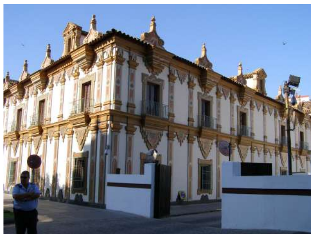
Fachada exterior de la ampliación
