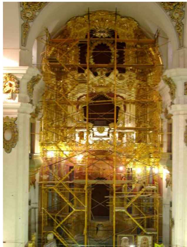
Vista general del retablo en construcción (Foto: Archivo fotográfico de la Diputación Provincial de Córdoba)
