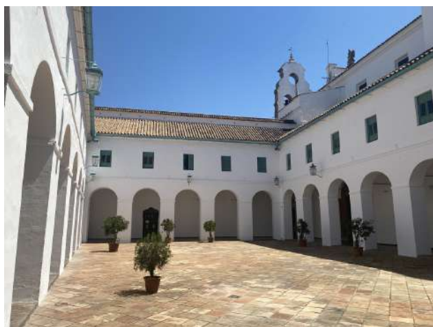
El patio blanco, que estructura la ampliación
