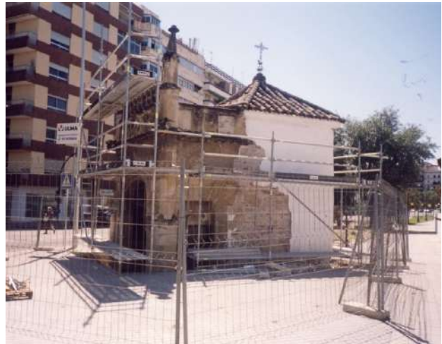
Obras de desmonte de la ermita en 2002. Foto Jesús Padilla
