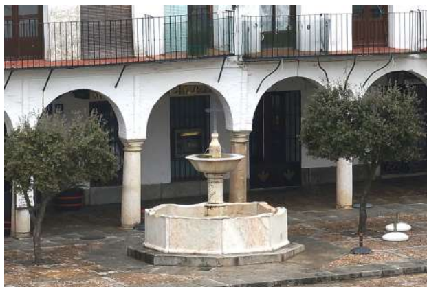
Fig 04.- Fuente de la plaza de España de Llerena. Estado actual.
