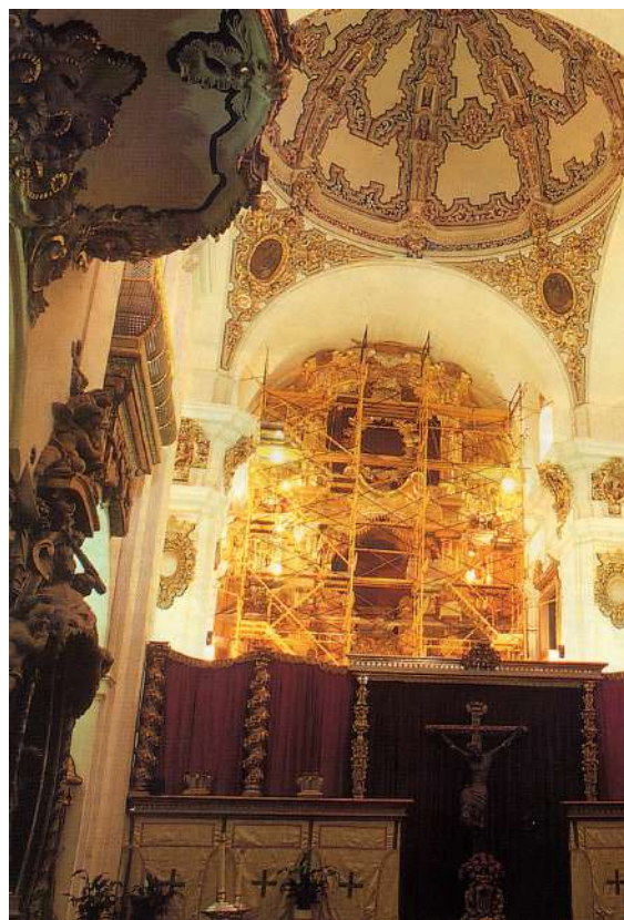
Iglesia de la Merced durante su restauración (Foto: J. Padilla)
