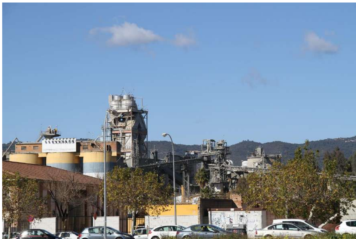
Cementera Cosmos y en primer plano el Colegio Público Concepción Arenal (Foto: J. Padilla)
