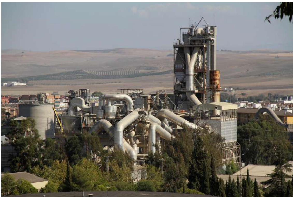
Cementera Cosmos de Córdoba (Foto: J. Padilla, 26/06/2015)
