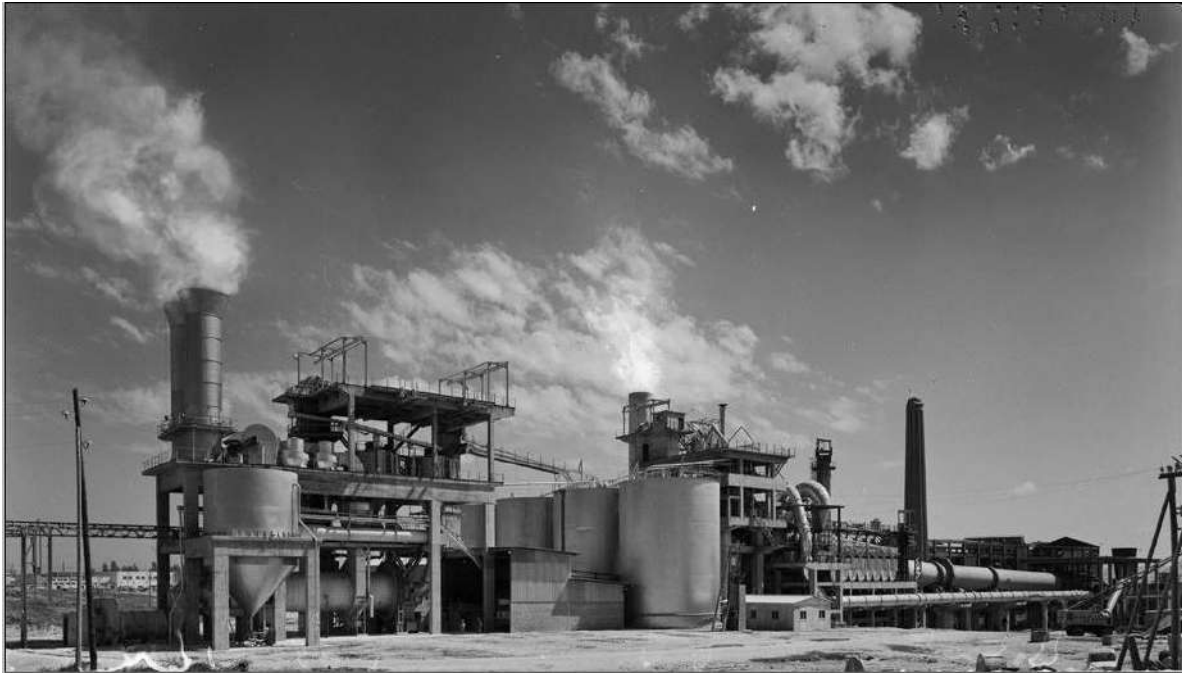
Vista general de las instalaciones de la cementera Asland de Córdoba (Foto: Juan Miguel Pando Barrero (1915-1992), fechada el 4 de abril de 1966) 126 .
