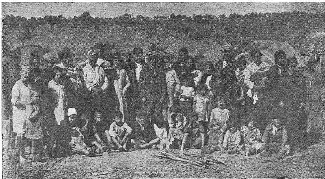
Chozos Arroyo de Pedroches incendiados en la noche del 11 de octubre de 1931 y fotografía de las familias afectadas. Fueron unos 20 chozos los incendiados, en los que vivían 13 familias integradas por 76 personas (LA VOZ, 12 de octubre de 1931).
