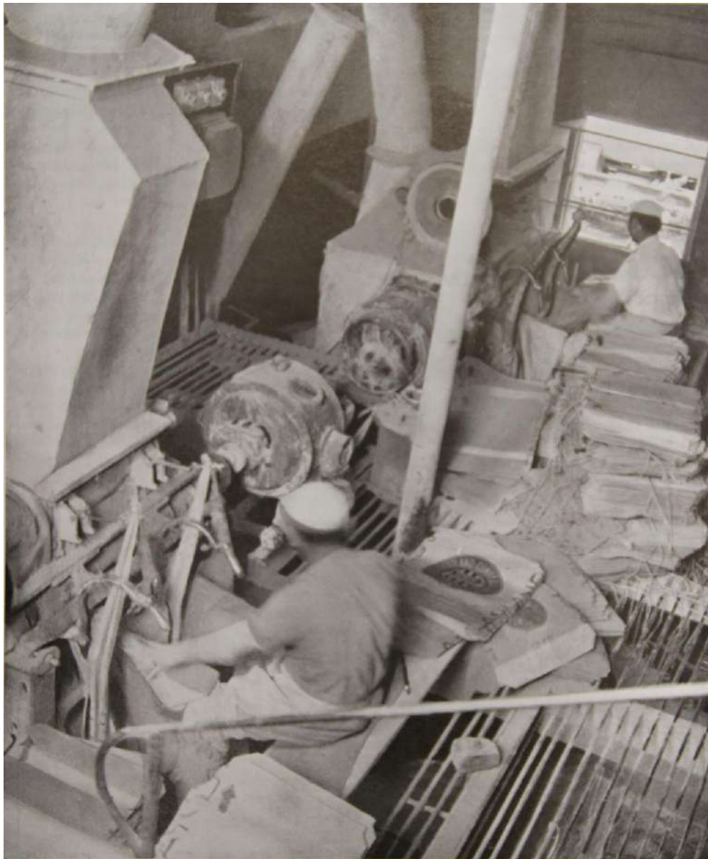
Detalle de la nave envasadora de la factoría de Cemento Asland de Córdoba, en 1964 (Foto: Jesús) 41
