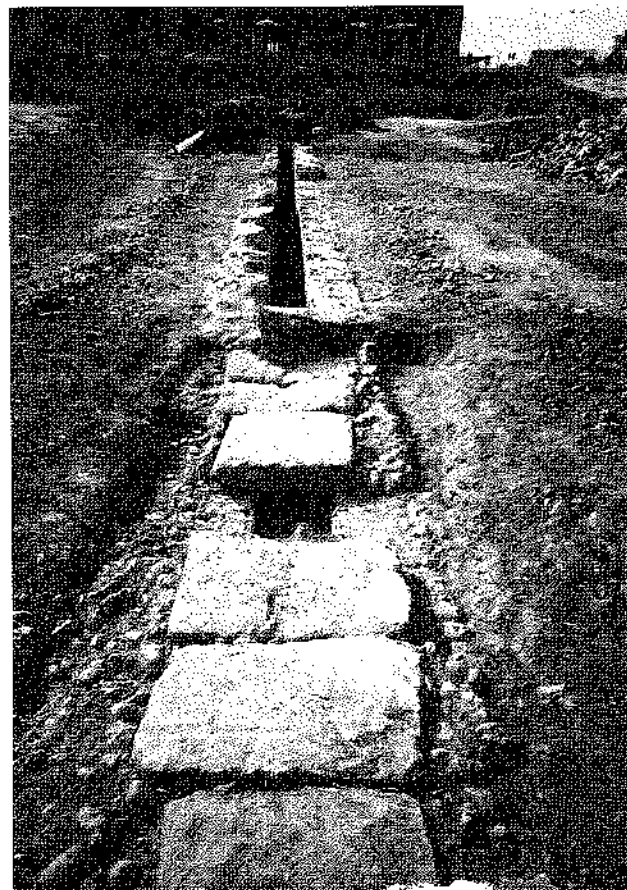
Lám. 1. Acueducto 1. En primer plano, restos de la que, muy posiblemente, constituía la cubierta originaria del Acueducto romano.
