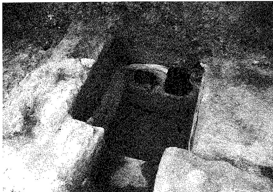
Lám. 3. Cabeza de sifón/castellum divisorio del Acueducto 1. Se aprecian las perforaciones para el ajuste de los cálices de bronce.
