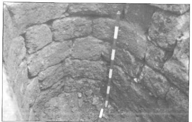
Lam. 4. Interior pozo noria.
