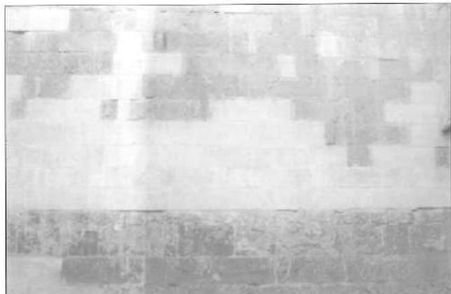
Fig. 6. Muro de la Mezquita-Catedral en el que se han reintegrado sillares.
