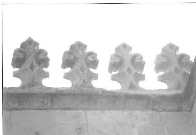
Fig. 7 y 8. Merlones y ménsulas reintegrados en la Mezquita-Catedral.
