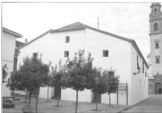
Panorámica exterior del edificio del Museo Municipal de Palma del Río. Foto: Pijuán.
