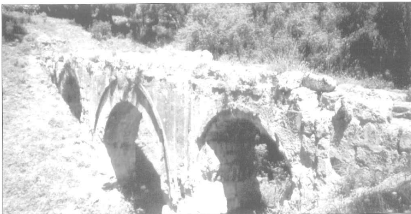
Fig. 4. Acueducto de Valdepuentes.
