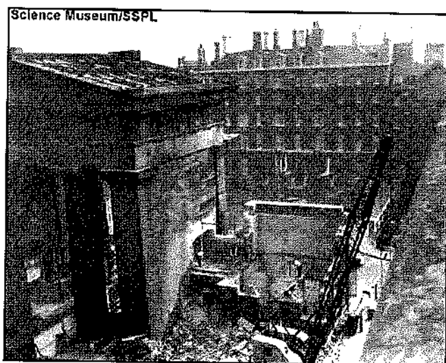
Obras de demolición de la Euston Station
