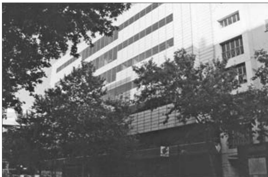
Figura 3: Fachada a la avenida de Ronda de los Tejares
