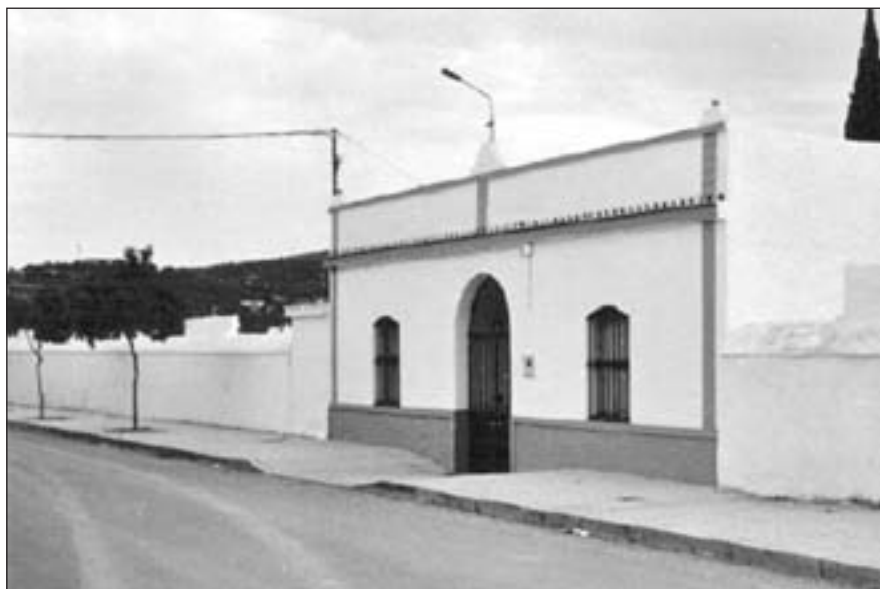
Fachada del cementerio municipal de Puebla de los Infantes.
