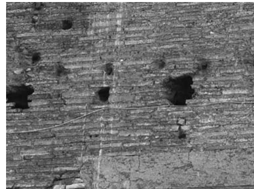
Figura 16: Detalle de los agujeros para la sujeción de las lastras marmóreas de la Forma.
