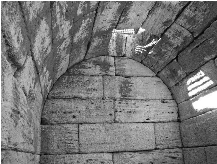
Interior del aljibe
