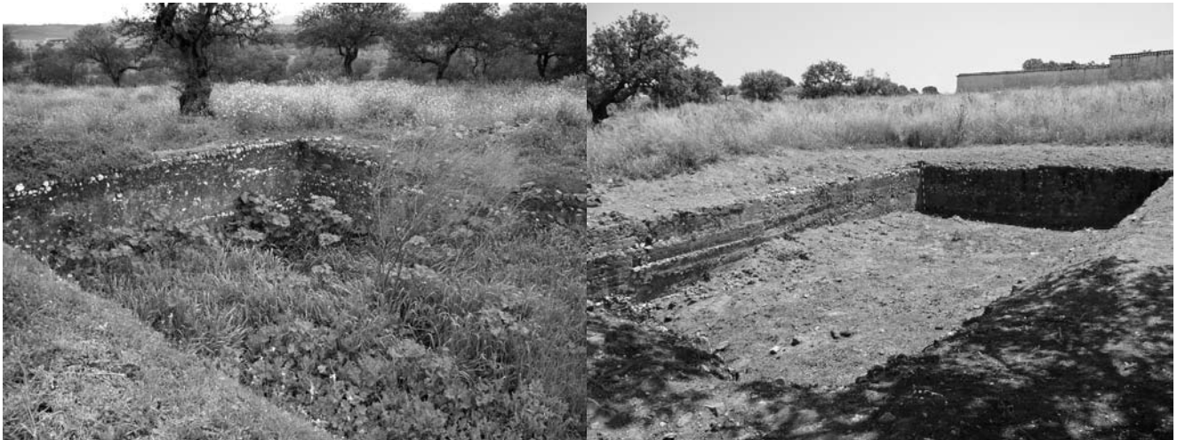
Figura 7: Antes y después en el proceso de limpieza de la cisterna superior. Foto: Esperanza Rosas
