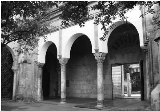
Puerta de la galería occidental Excavación del año 1999
