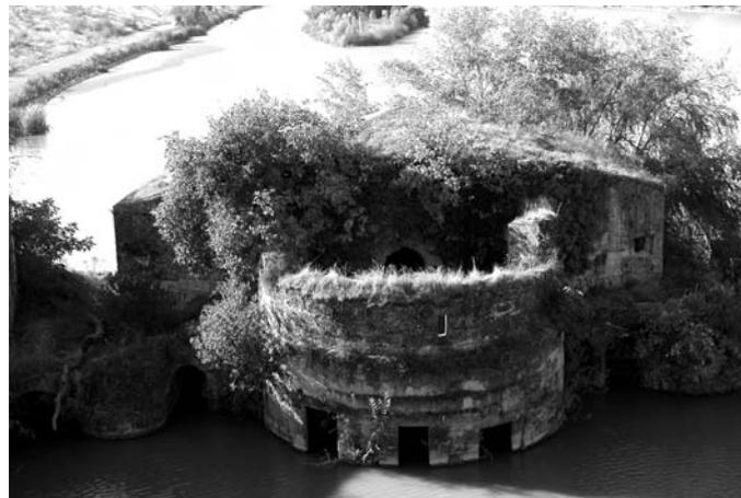
Fig. 17. El molino de San Rafael fue edificado en 1844 sobre los restos del antiguo molino del Duende, al que podría pertenecer la zona en forma de ábside que enfrenta a la corriente, característica de las antiguas aceñas. (Foto: R. Córdoba).
