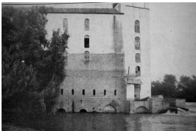
Fig. 16. Vista frontal del molino en 1933; la parte inferior, no enalada y construida en sillería, se corresponde con el molino original de 1834 (Estadística de los aprovechamientos hidráulicos existentes en la actualidad en el río Guadalquivir, Confederación Hidrográfica, Sevilla 1933).
