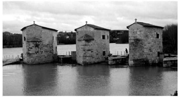
Fig. 1. Los molinos de Pápalo, Enmedio y San Antonio, situados por debajo del Puente de Córdoba, conservan una planta con la característica forma de aceña del Guadalquivir, rematada en ábside semicircular por su partes superior (Plano: J. Cuenca). En cambio, las del Duero suelen presentar en su cabecera forma de tajamar para encauzar las aguas. (Aceñas de Olivares, Zamora. Foto: J. M. Garrido).
