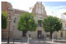
Fachada del Ayuntamiento de Fuente Palmera (Fotografía. A. Hamer)
