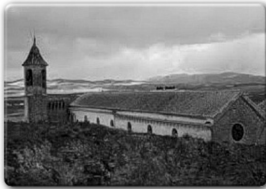
Vista fachada lateral Parroquia del Soterraño En Aguilar de la Frontera
